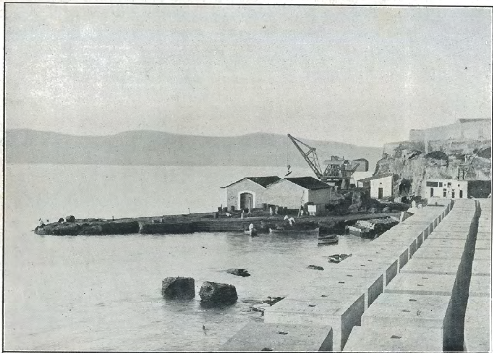
PUERTO DE CHAFARINAS.—VISTA PARCIAL DEL TALLER DE BLOQUES Y GRÚA TITÁN
