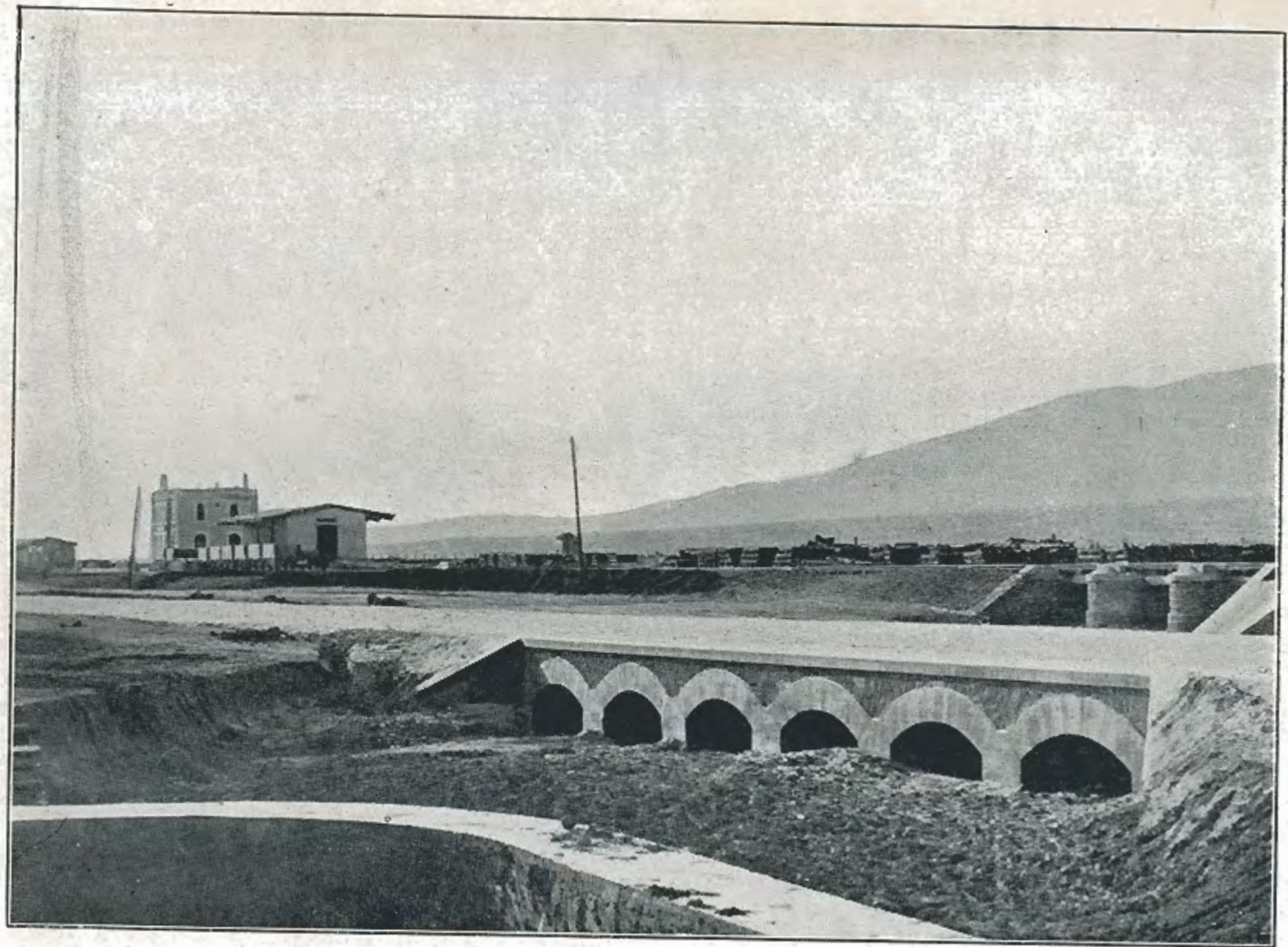
ALCANTARILLA DE LA CARRETERA DE MELILLA A MAZUZA
