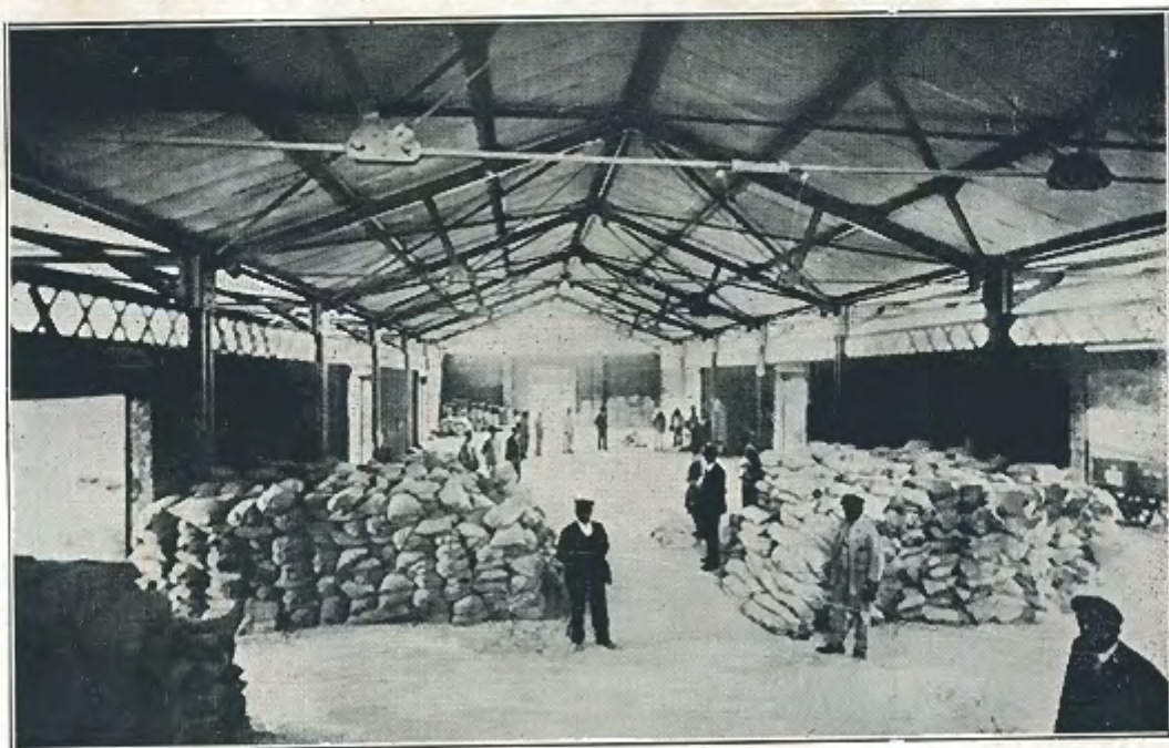
TINGLADO METÁLICO EN EL MUELLE DE SANTA BÁRBARA
