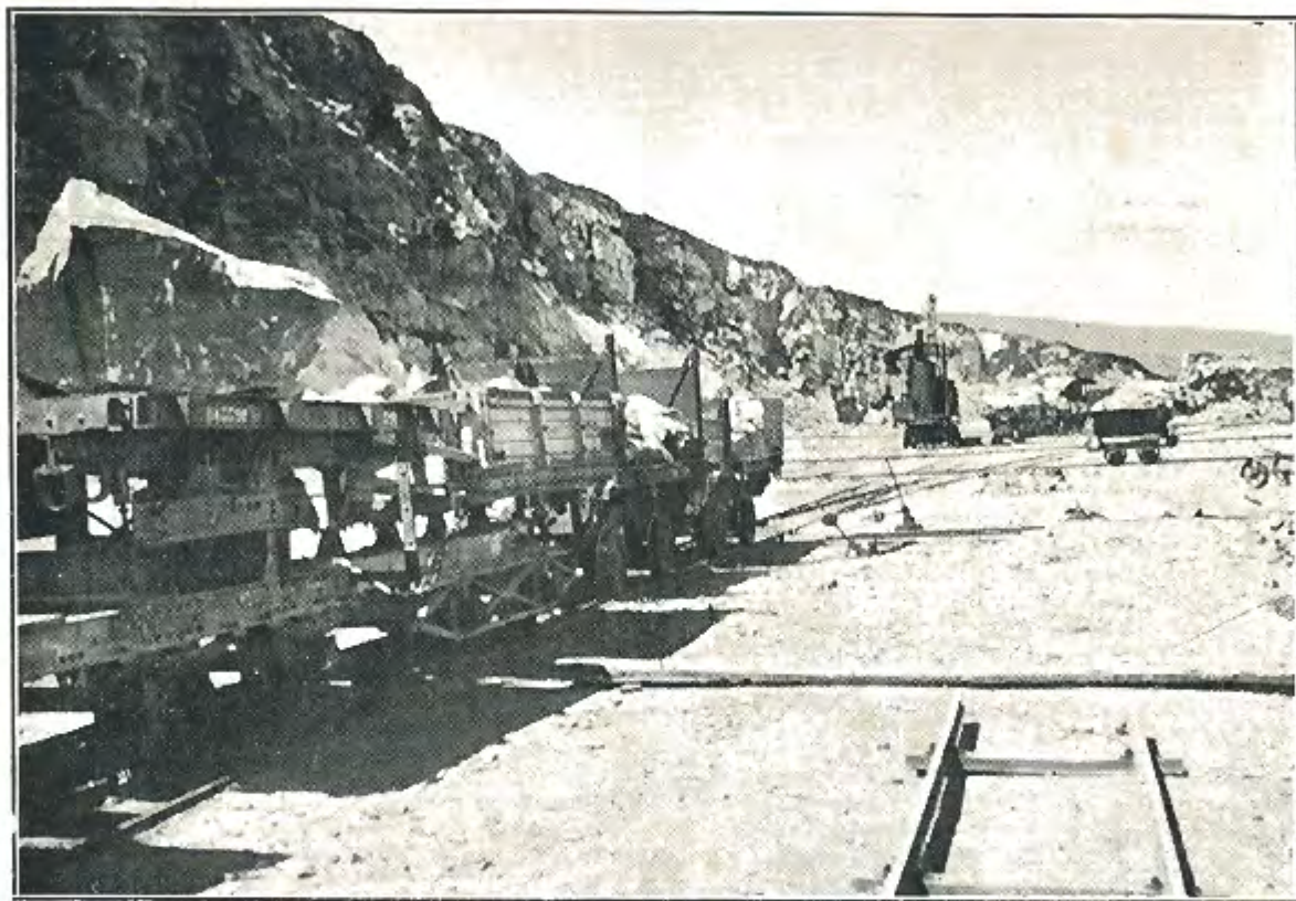
CANTERAS DE SIDI-MUSA.—TRINCHERA DE RECTIFICACIÓN
