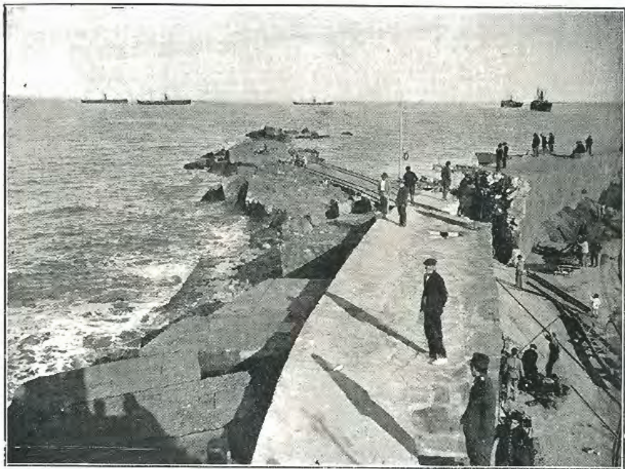
TEMPORAL DE MARZO DE 1925.—VISTA GENERAL DE LA OBRA DE PROLONGACIÓN
