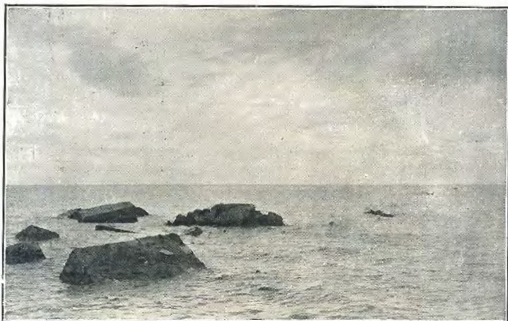
TEMPORAL DE NOVIEMBRE DE 1924.—EXTREMO DE LA OBRA DE PROLONGACIÓN
