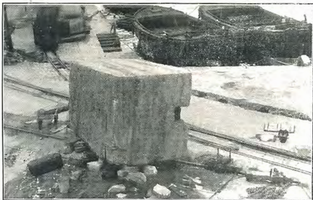
TEMPORAL DE NOVIEMBRE DE 1924. BLOQUE DE 40 TONELADAS, ARRASTRADO POR EL TEMPORAL
