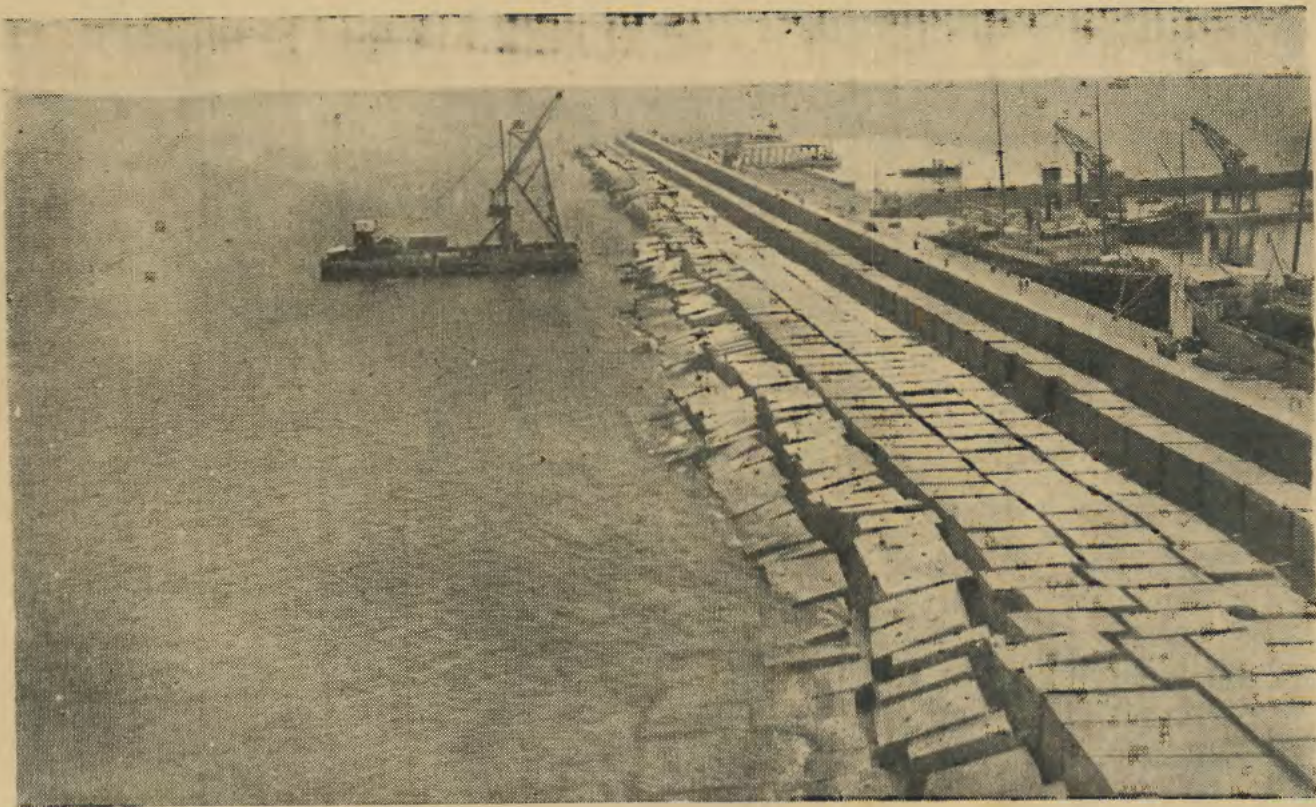
Defensa de la 1. a alineación del Dique N. E. durante la construcción
