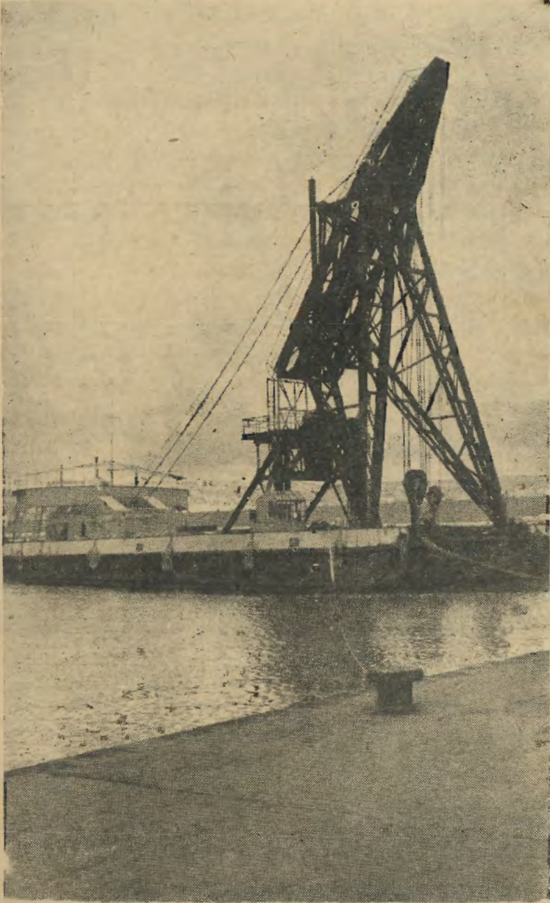
Grúa flotante de 80 toneladas
