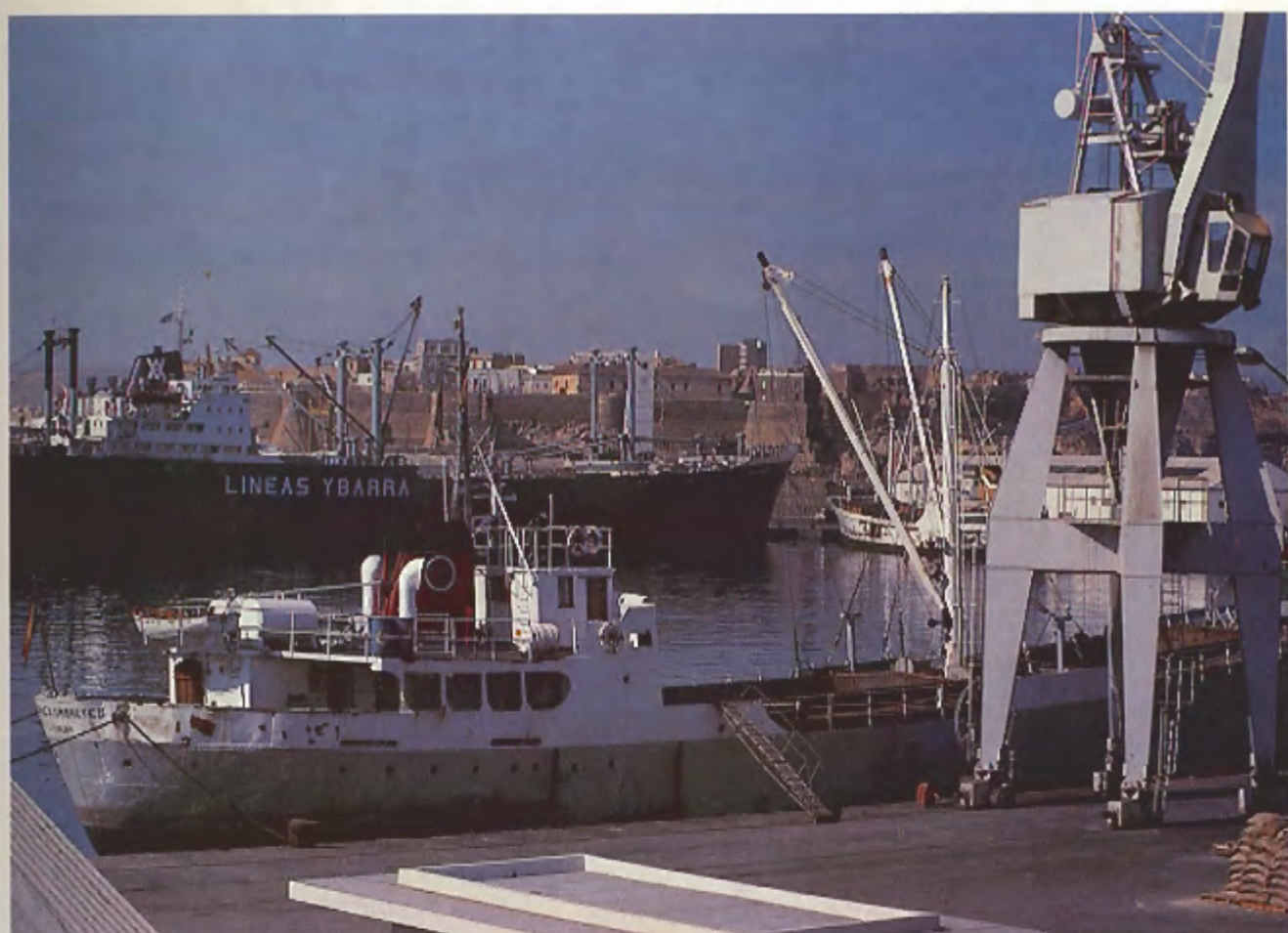
Vista del Puerto.
