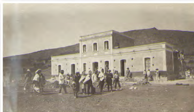
Manuel Becerra y la estación de ferrocarril en Nador 1908.
