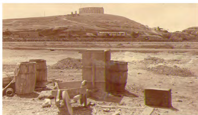
Cerro de San Lorenzo e inicio construcción del taller de bloques en Melilla 1905.
