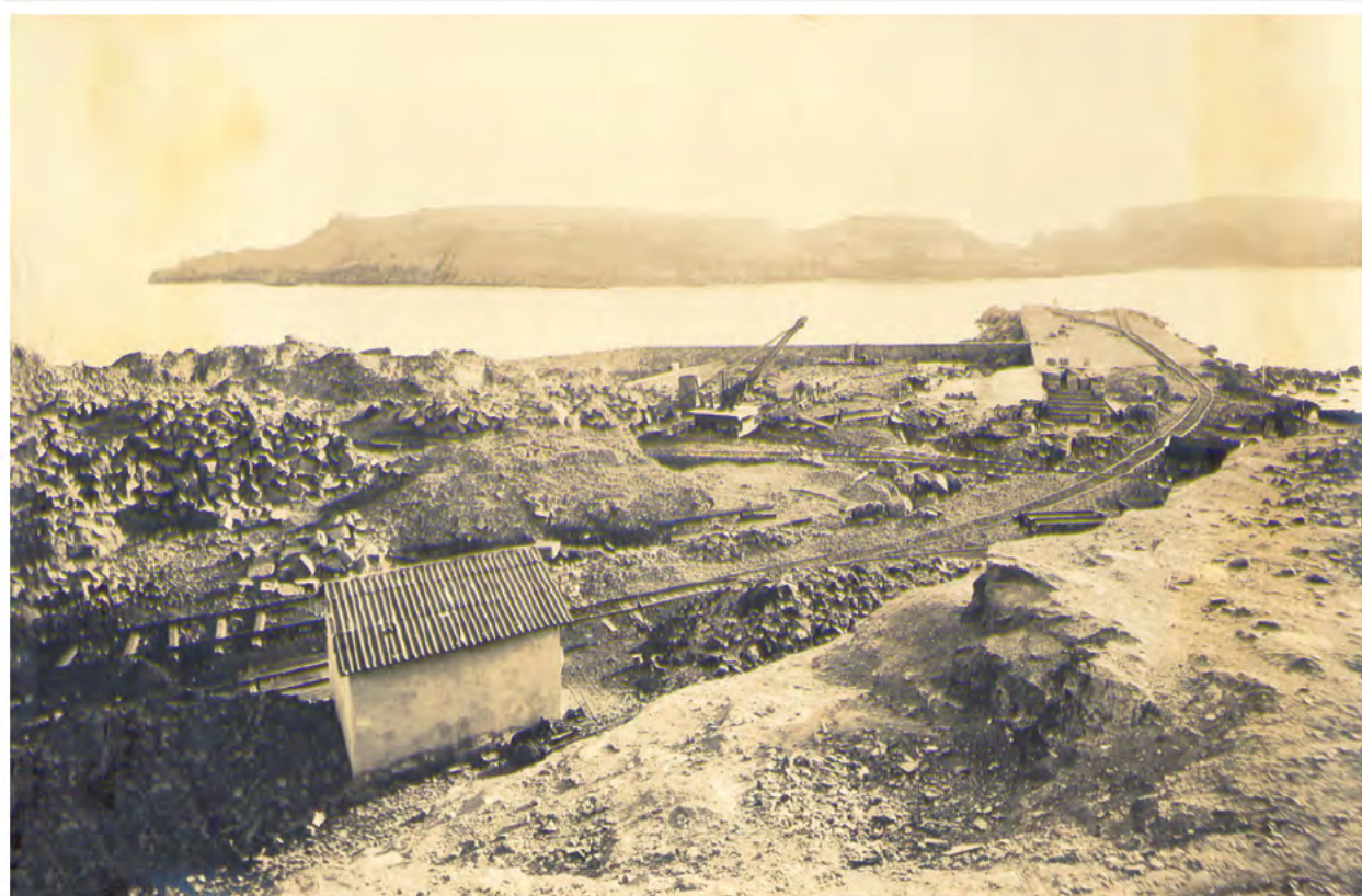
Inicio construcción puerto de Chafarinas 1906.
