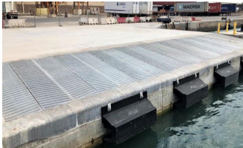
Figura 25: Tacón Ro-Ro en el muelle Nordeste
