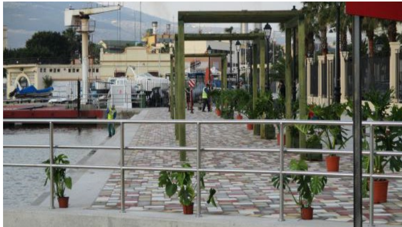
Figura 28: Explanada habilitada en la dársena de pesqueros
