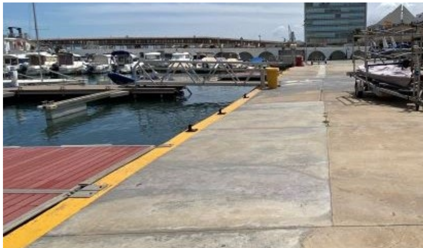
Figura 29: Muelle náutico deportivo del Real Club Marítimo
