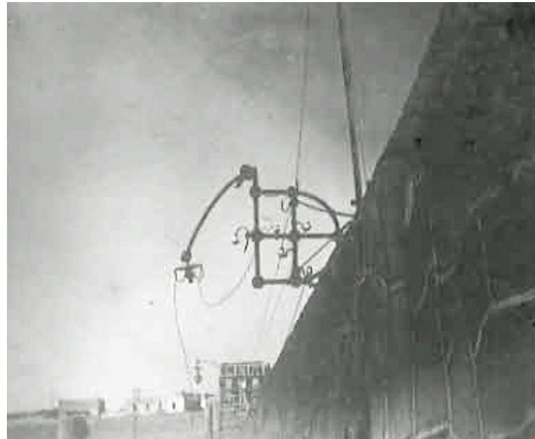
Soporte de luz en el espaldón del muelle Villanueva.
